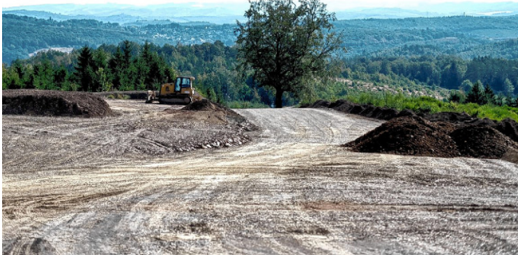
Aktuell laufen die Tiefbauarbeiten für den Windpark Kreuzeiche in Siegen. Das Gelände muss vorbereitet werden für den Transport der riesigen Windrad-Teile und das Aufstellen der Kräne.
