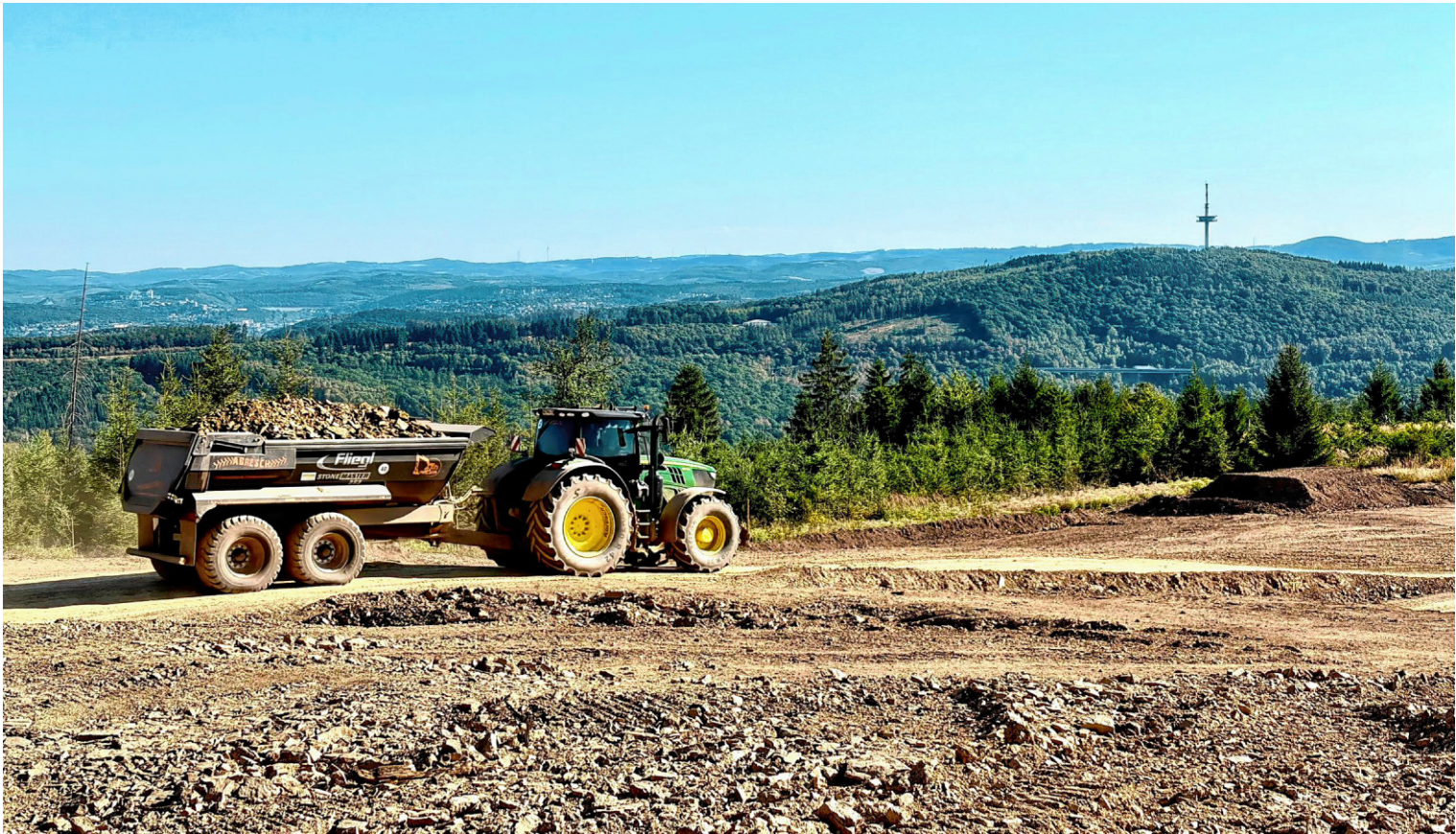
Erdbewegungen auf dem „Dach des Siegerlands“: Auf dem Pfannenberg zwischen Siegen (hinten die Eisernhardt) und Neunkirchen errichten die Grünwerke den ersten Windpark der Stadt - die vier Windräder werden jeweils insgesamt rund 250 Meter hoch sein.
